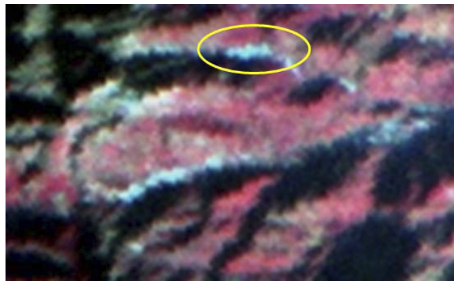
図 3 崩落現場(2008.12/4 撮像)切出し画像
